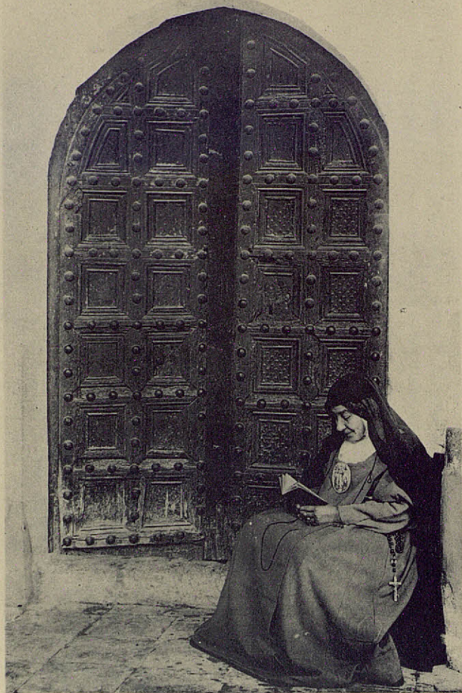
Puerta de la cocina recayente al claustro.
