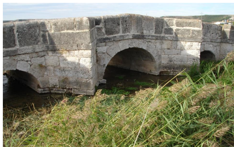
Puente del Botijas lado sur
