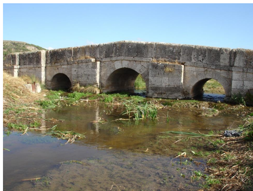
Puente del Botijas lado Norte
