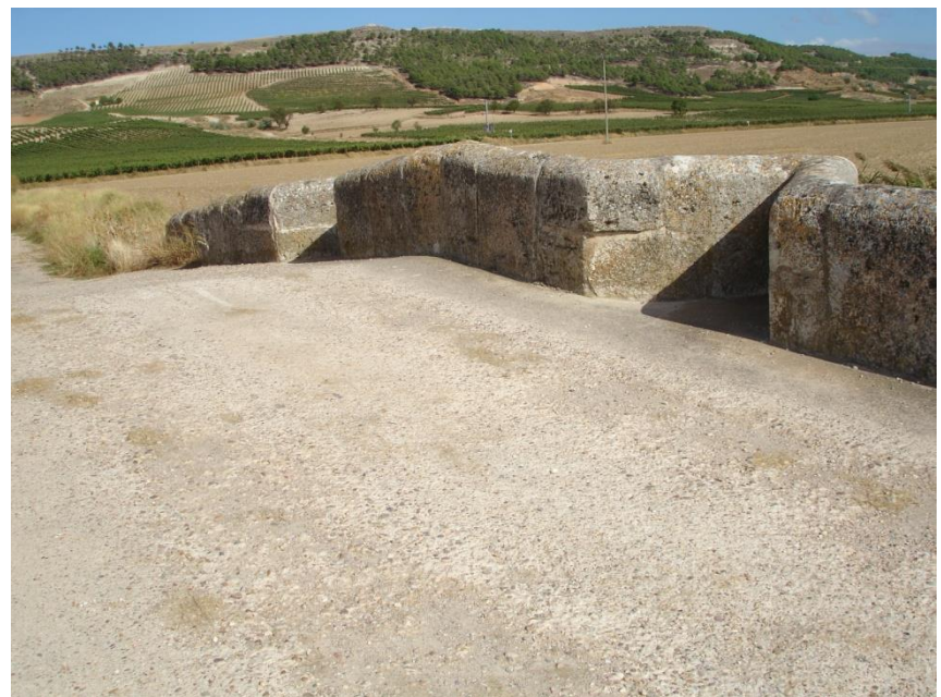
Puente recubierto de hormigón
