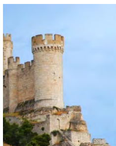
Proa del castillo. Abajo se ve un portillo de la contramuralla hoy cegado.
