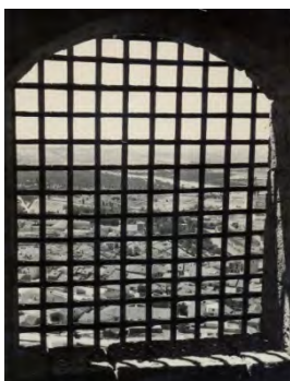
Salón principal, única ventana que conserva la verja original.
