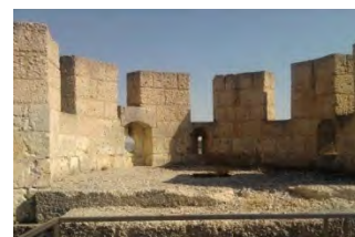
Cubo del patio Sur, se ve una cañonera, dos saeteras y el hueco de entrada al calabozo
