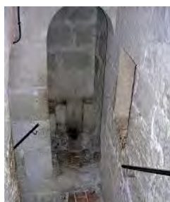
Letrina en un hueco de la escalera entre la 1ª y 2ª plantas.
