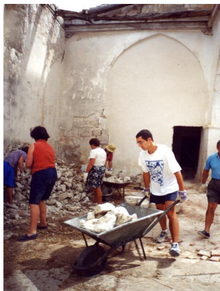
Voluntarios trabajando en el desescombros 1998
