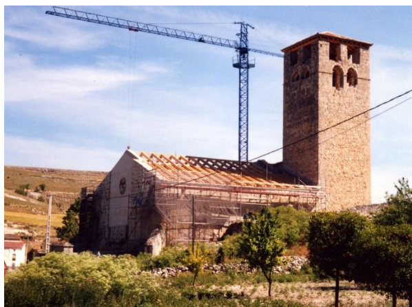
Reconstrucción de muros y cubierta. 2001.
