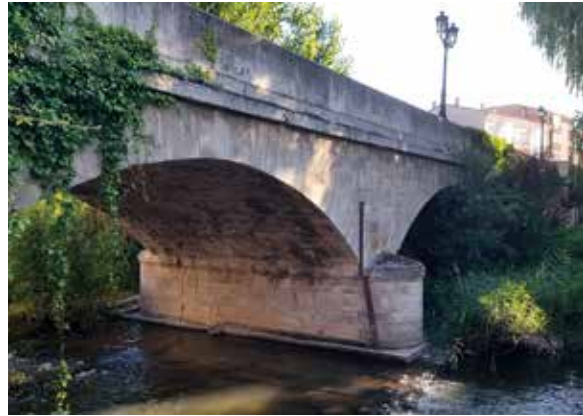
Fig. 6. Vista del puente en la actualidad, aguas abajo (fotografía de Juan José Moral Daza).
