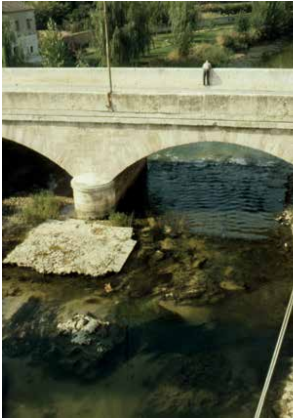
Fig. 7. El puente nuevo, aguas arriba, 1988. Vemos la cepa de la 2.ª pila del puente anterior (fotografía de Juan José Moral Daza).
