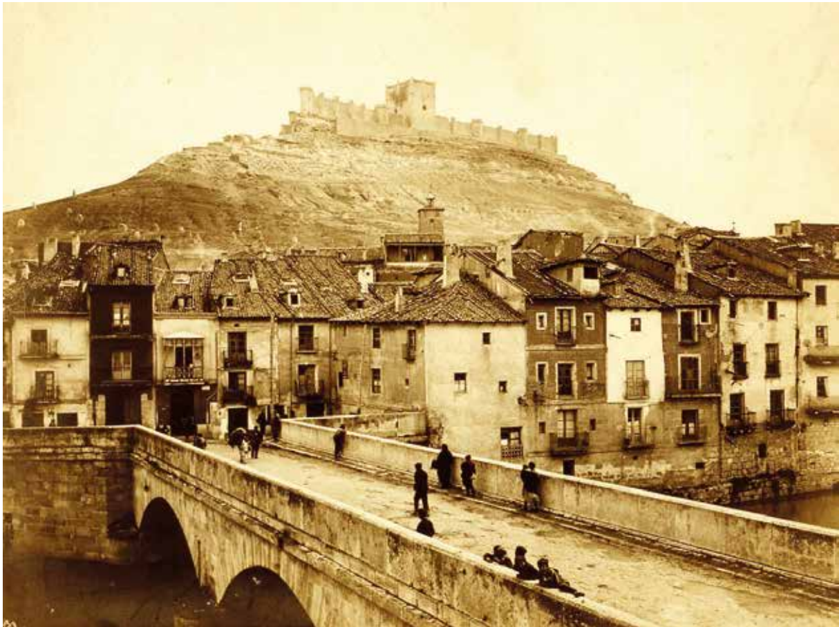
Fig. 4. Vista del puente, barrio de Santa María y castillo, hacia 1925 (colección fotográfica de Juan José Moral Daza).
