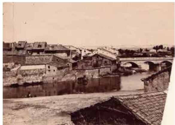
Fig. 1. Vista parcial del puente, con el barrio del Mercado, desde la Judería, poco antes de 1892. Fotografía de Julio Lapeira (colección fotográfica de Juan José Moral Daza).
